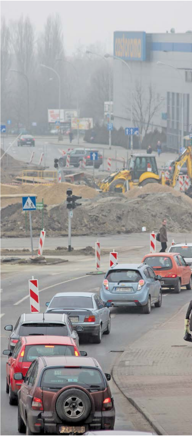
Z ruchu wyłączono już wewnętrzny pierścień skrzyżowania
