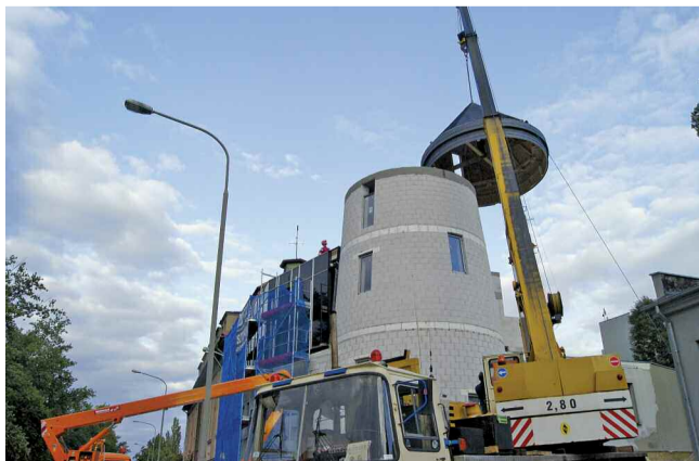
Montaż kopuły wiatraka – 15 września 2011 r.
