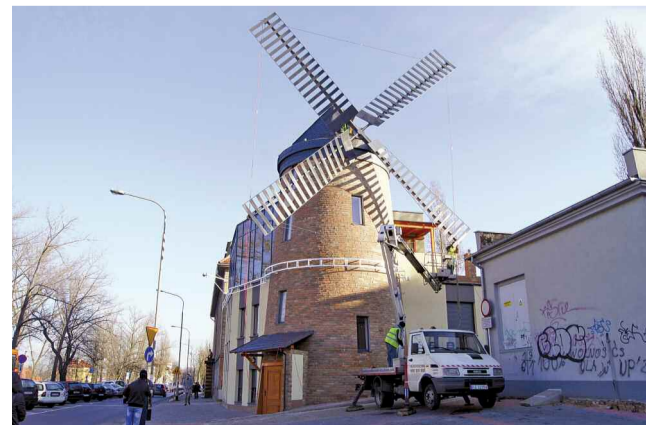
Sobota, 1 grudnia 2012 r. – montaż skrzydeł wiatraka
