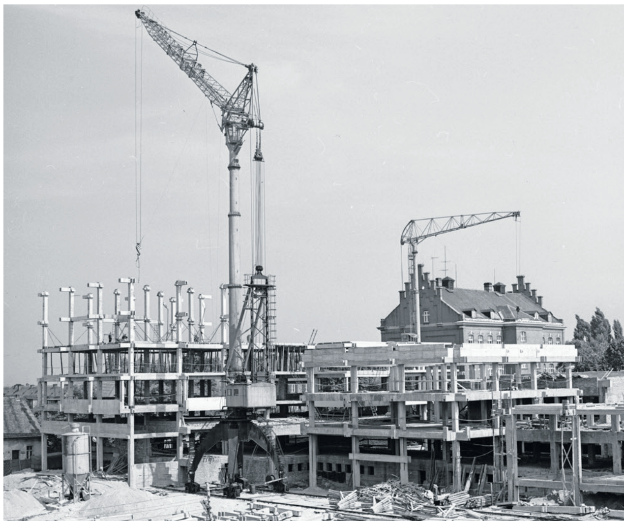
Wielki żuraw na budowie wieżowców nowego centrum. Na drugim planie budynek Ośrodka Doskonalenia Nauczycieli przy ul. Chopina. Lato 1970 r.
