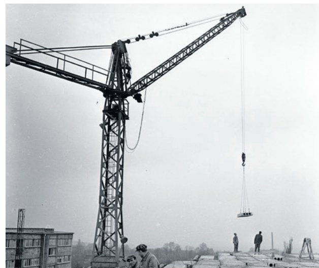
Kwiecień 1965 r. Robotnicy montują strop jednej z kondygnacji.
