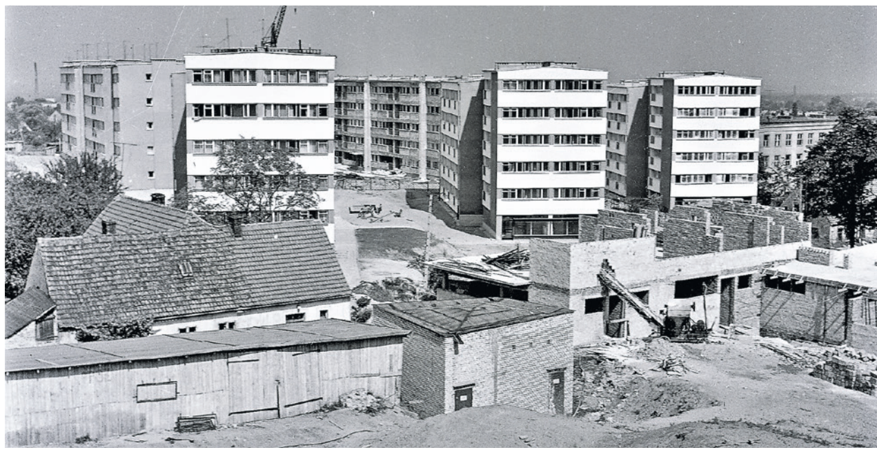
To samo miejsce kilka miesięcy później. Trwa budowa poczty.
