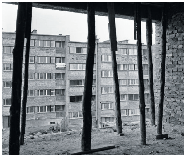
Kwiecień 1965 r. Trwa budowa - w gotowym bloku obok ktoś wietrzy pierzynę.
