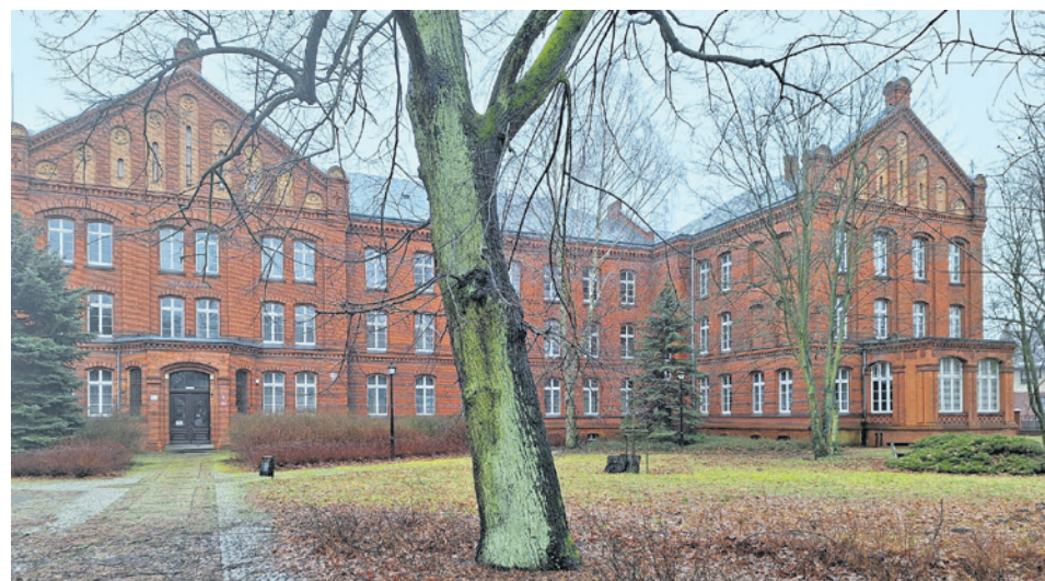
Na sprzedaż trafiły charakterystyczne budynki z czerwonej cegły
