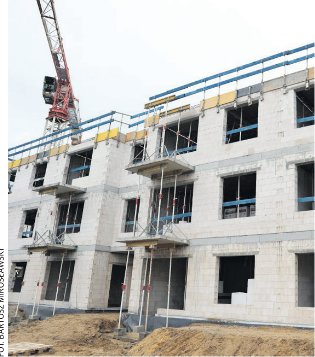
Widać już ściany bloków przy ul. Suwalskiej
