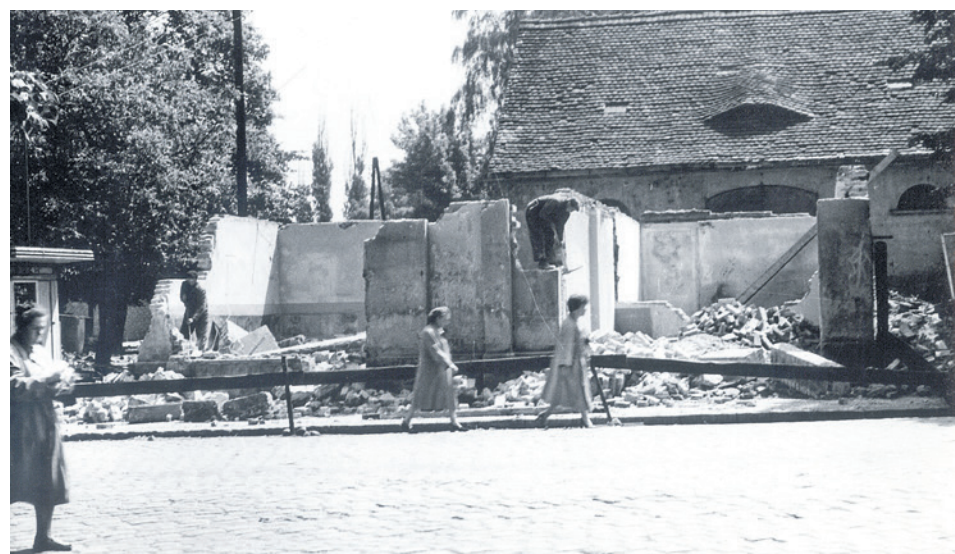
Rozbiórka budynku, w którym kiedyś mieścił się bar mleczny nr 3. Zburzono również budowlę na zapleczu baru.
