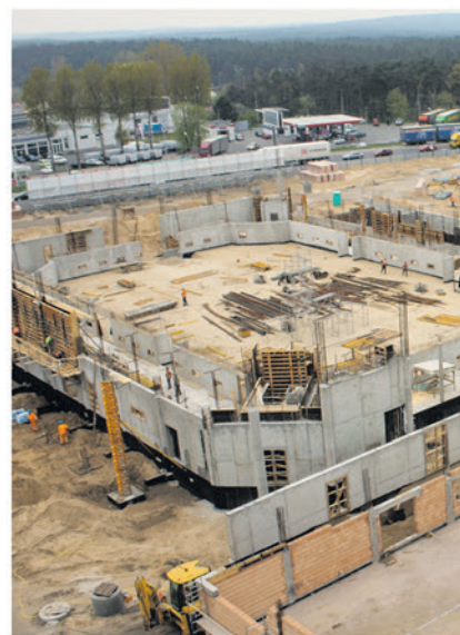
Roboty ziemne przy budowie CRS w czerwcu 2010 r.
