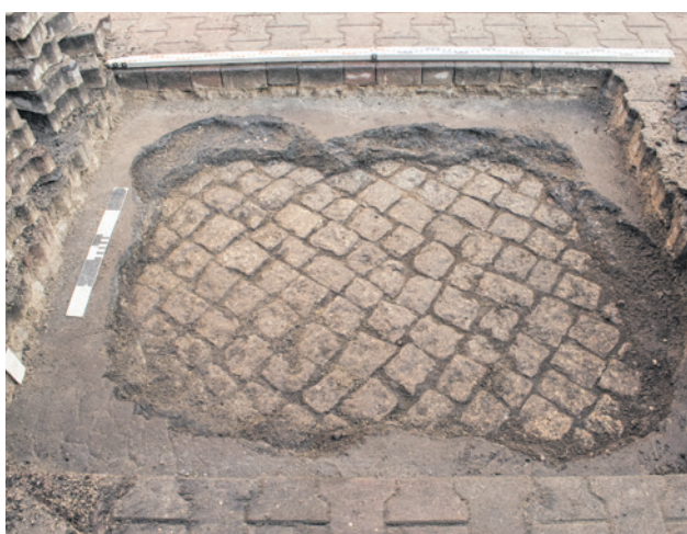
Wykop pod nasadzenie drzew - widać pierwszą warstwę bruku
