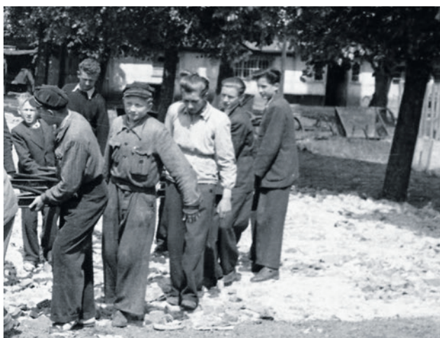
Uczniowie Zasadniczej Szkoły Zawodowej pomagają na budowie - czerwiec 1955 r.
