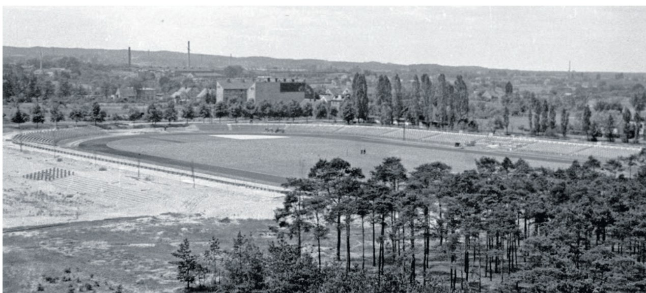
Widok na budowany stadion z wieży spadochronowej - lipiec 1955 r.
