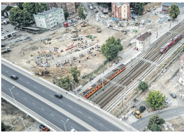
Plac budowy w lipcu 2018 r.
