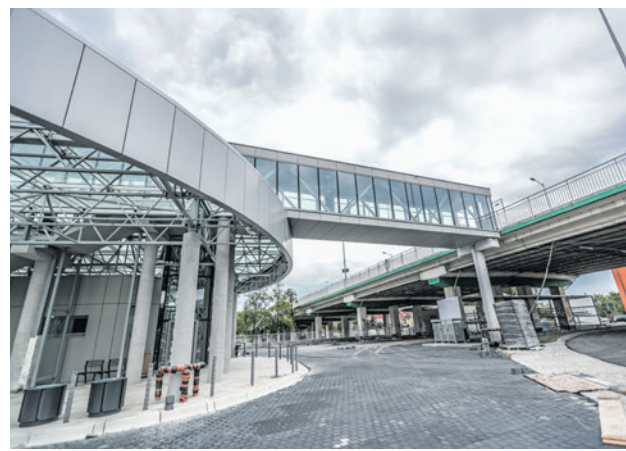
Maj 2019 r. - budynek jest już gotowy
