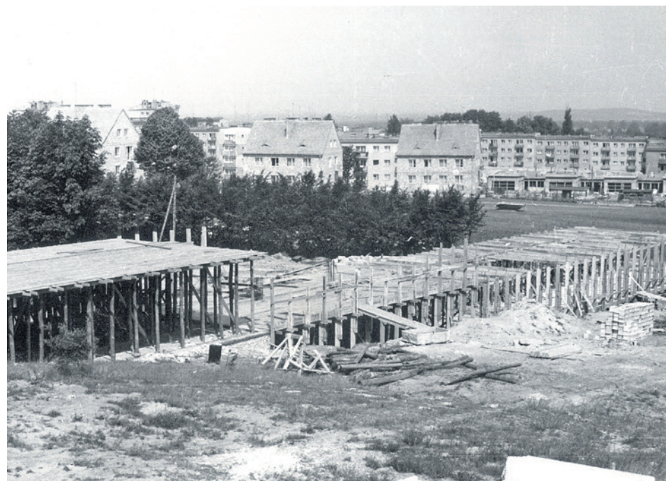
Początek budowy gmachu głównego WSI
