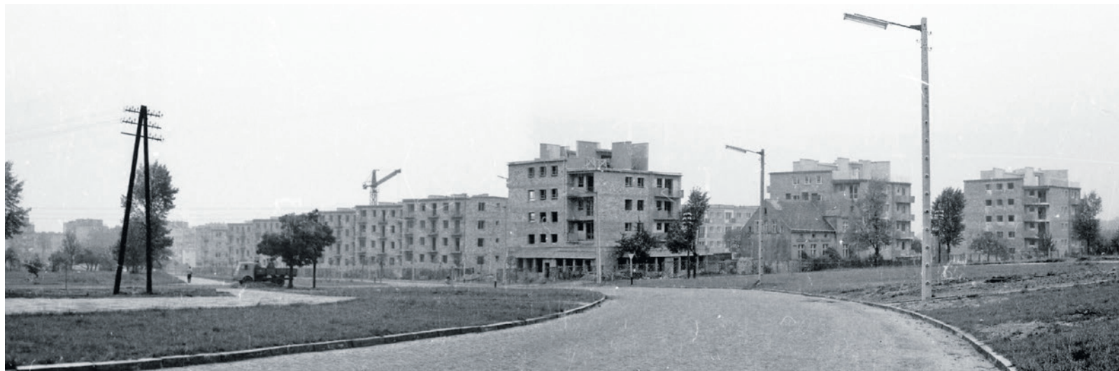
Budowa os. Wazów III wzdłuż ul. Podgórnej i Waryńskiego. Wszystkie zdjęcia opublikowano w wydaniu „Gazety Zielonogórskiej” z 6 października 1962 r.
