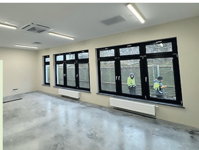
Od podstaw powstał nowy budynek parterowy o pow. 330 mkw., składający się z pięciu sal wykładowych oraz pomieszczeń pomocniczych
