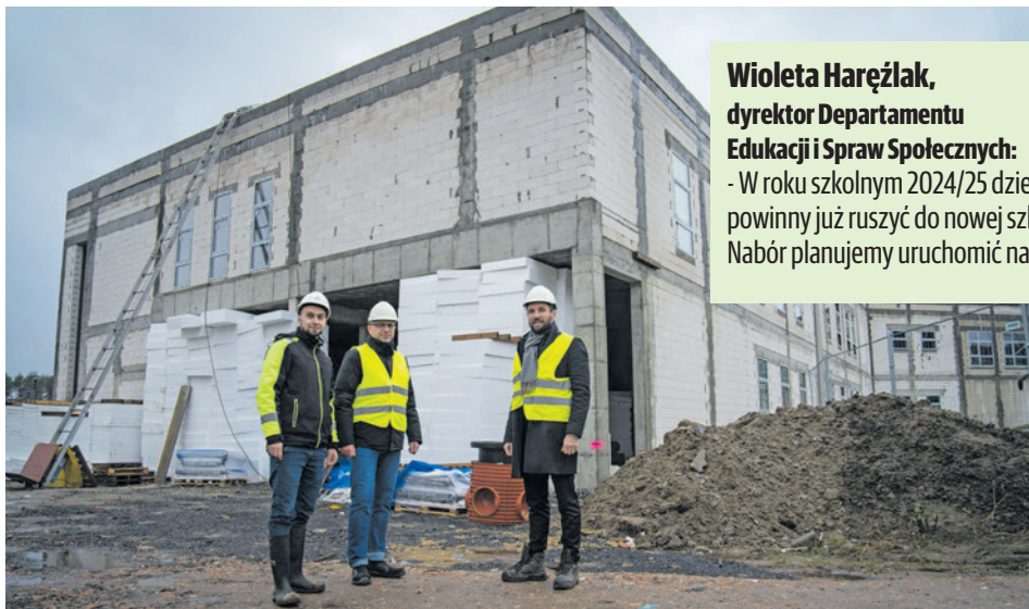
Radny Filip Gryko był jednym z organizatorów konsultacji społecznych w Łężyca w sprawie budowy szkoły, teraz sprawdza, czy na budowie wszystko idzie zgodnie z planem
