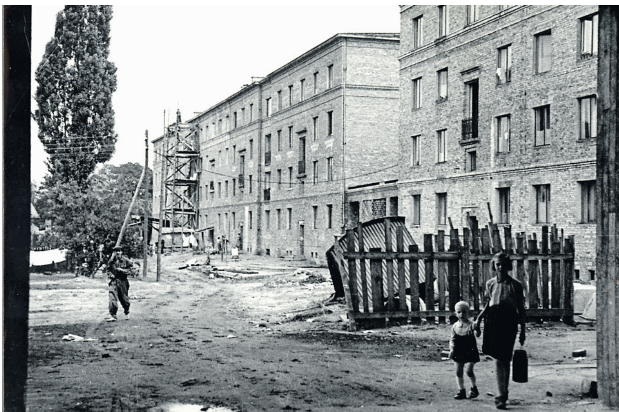
Pierwsi mieszkańcy, idąc do domu, musieli przedzierać się przez budowę
