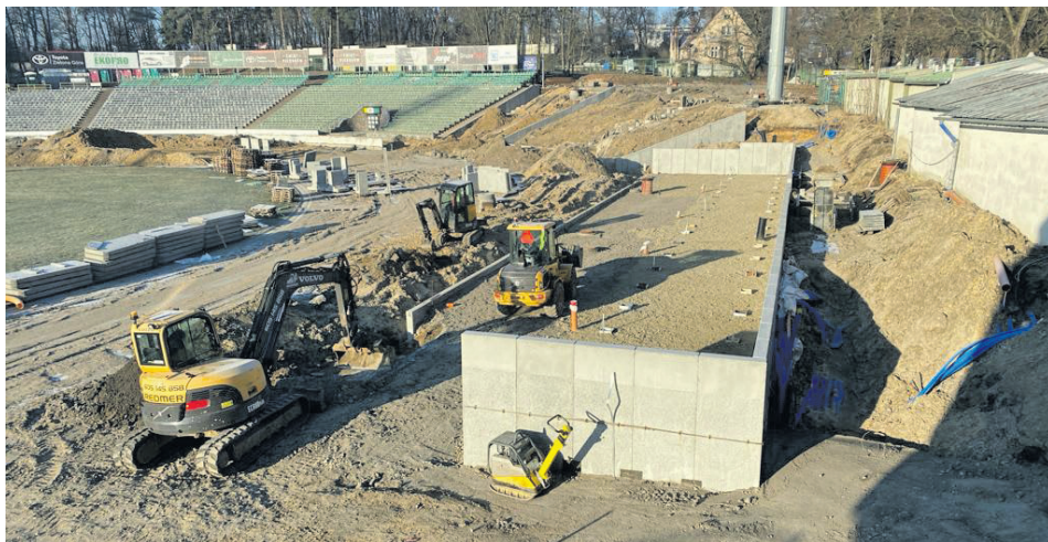
Na wejściu w drugi łuk trwają prace związane przede wszystkim z budową parku maszyn, który będzie odpowiadał standardom ekstraklasowym
