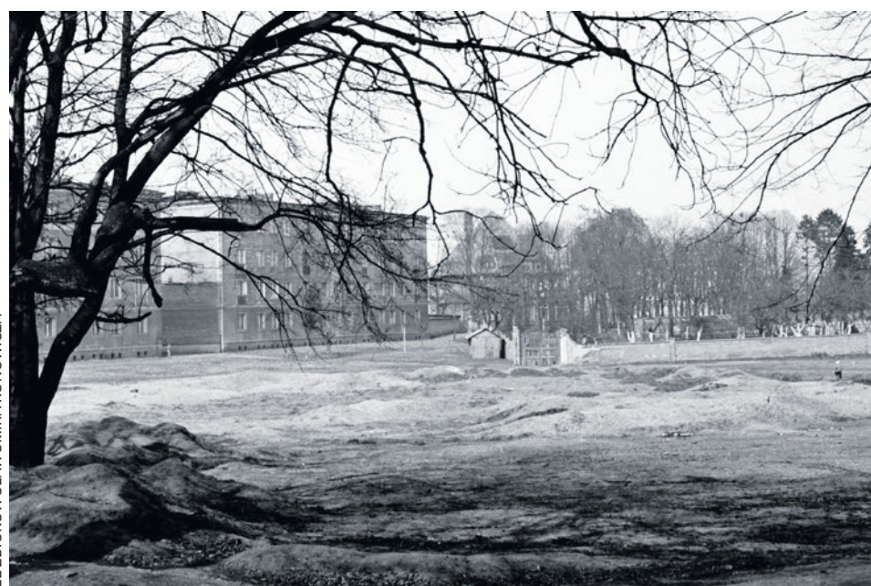
Przy tych blokach miała przebiegać autostrada oddalona od budynków o 20 metrów
