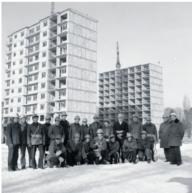
Luty 1972 r. - koniec montażu wieżowców przy ul. Krzywoustego
