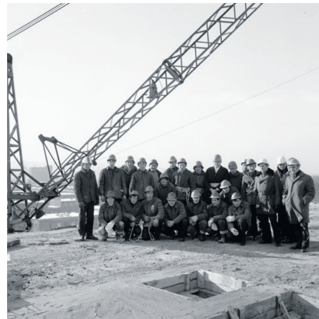
Uczniowie z budowlanki ZPB wraz z instruktorami na dachu wieżowca
