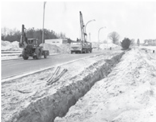
7 kwietnia 1977 r. Główna nitka Trasy Północnej jest gotowa. Trwają prace na poboczach, gdzie położono sieci komunalne. Fot. Bronisław Bugiel
