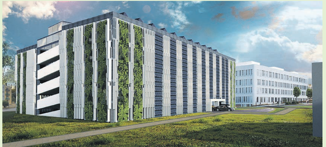
Elewacja zachodnia. Wjazd na parking – widok od strony szpitala.
