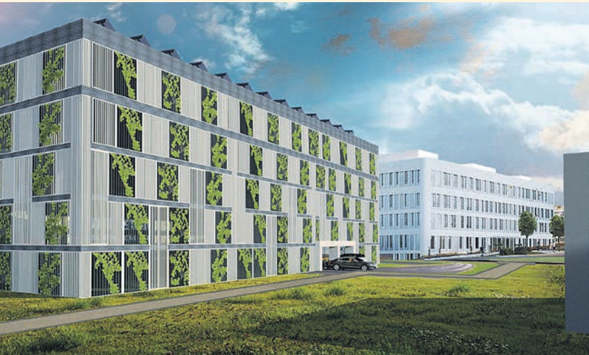
Wjazd na parking – widok od strony szpitala.
