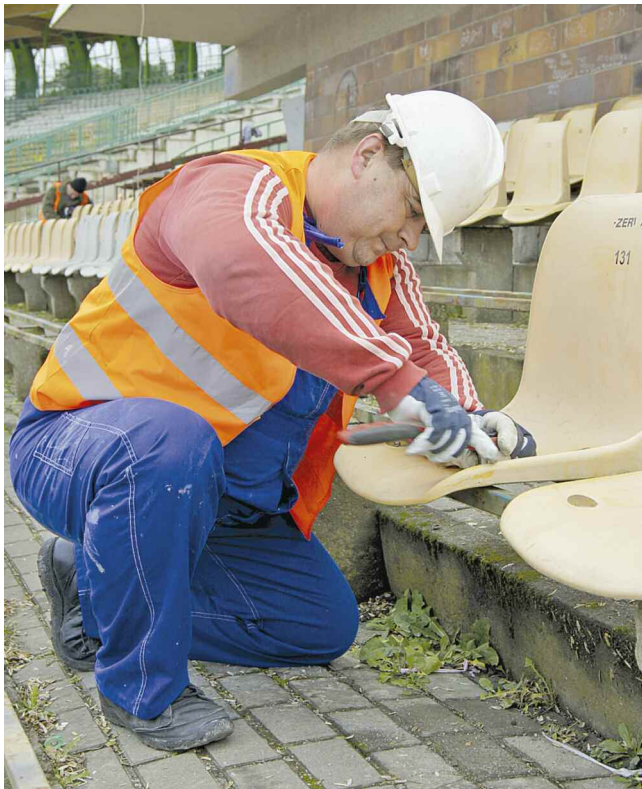
Pracownicy wrocławskiej firmy Sport Halls kończą drobne roboty przygotowawcze. Usuwają wysłużone krzeselka. Fot. UM
