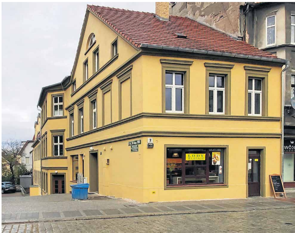
Nową elewację ma budynek przy ul. Sobieskiego 9
