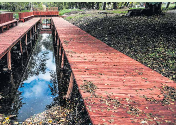
powstają pomosty. Po zamontowaniu siatek będzie można leżeć Fot. Piotr Jędzura
