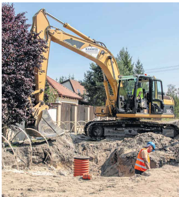
Prace przy budowie kanalizacji w Zatoniu, sierpień 2019 r. Obecnie sieć już jest gotowa. Fot. Materiały ZWiK
