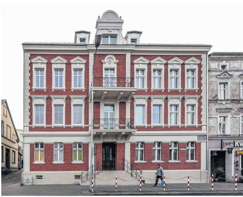
Pięknie wygląda front z klinkieru w kamienicy przy ul. Wyspiańskiego 2 Fot. Piotr Jędzura
