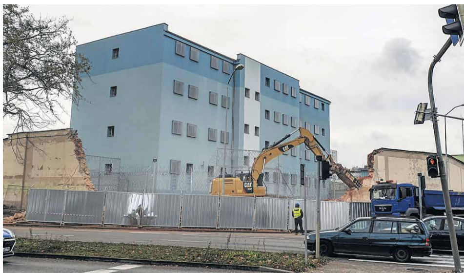
Mur aresztu śledczego znika. Zostanie odbudowany w ciągu trzech miesięcy.
