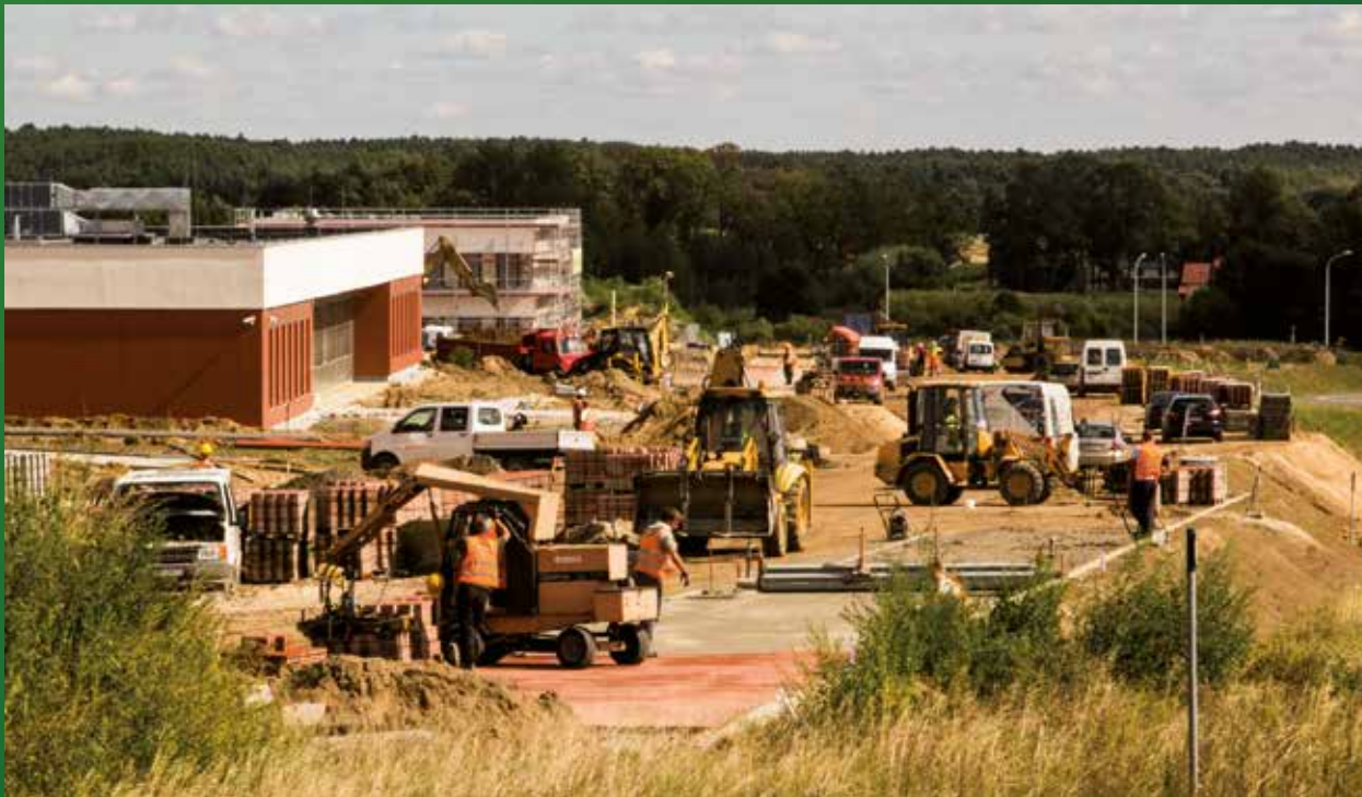
Budowa parku technologicznego w Nowym Kisielinie, 3 września 2013 r.
