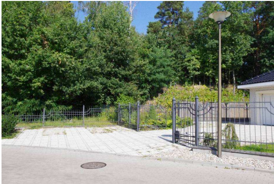
Fot. 7.39. Lokalizacja szybów wentylacyjnych pokładu szybu 15, ul. Kamionkowa
