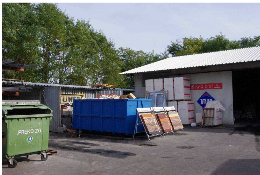
Fot. 7.51. Lokalizacja szybu nr 18, pod halą magazynową firmy „Kaidar”
