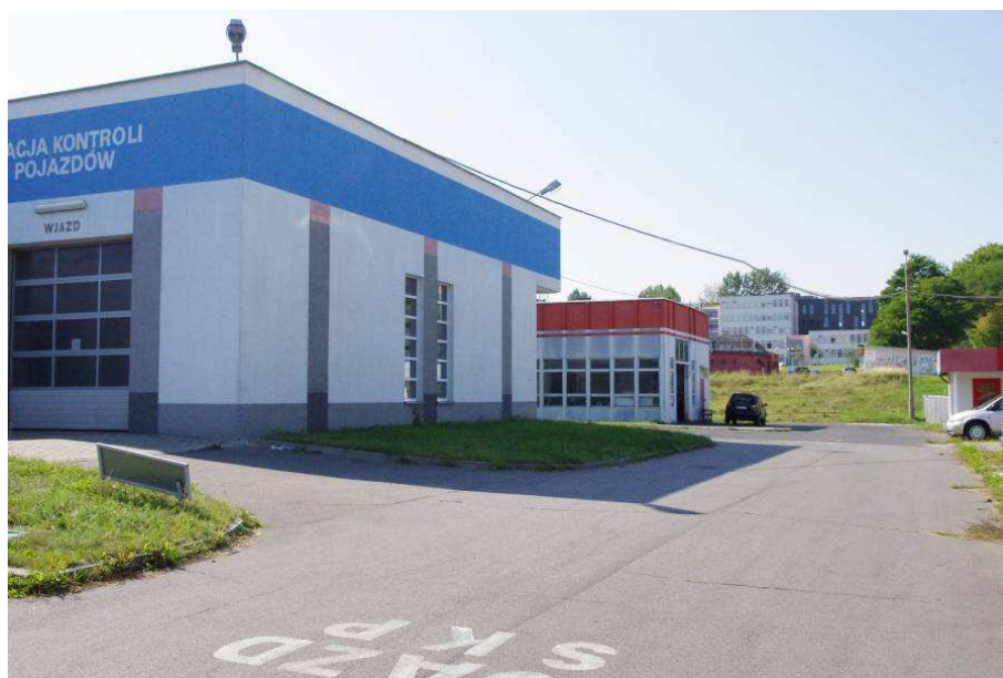
Fot.7.54. Lokalizacja szybu No 17, przy stacji kontroli pojazdów Polmozbytu.
