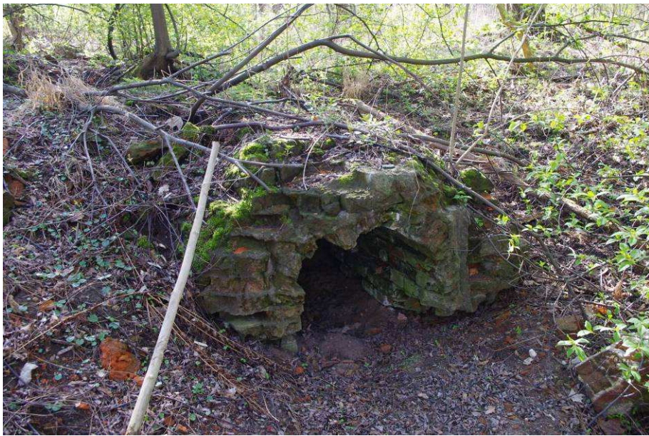
Fot. 7.23. Fragmenty infrastruktury kopalnianej w rejonie szybu Förderschacht
