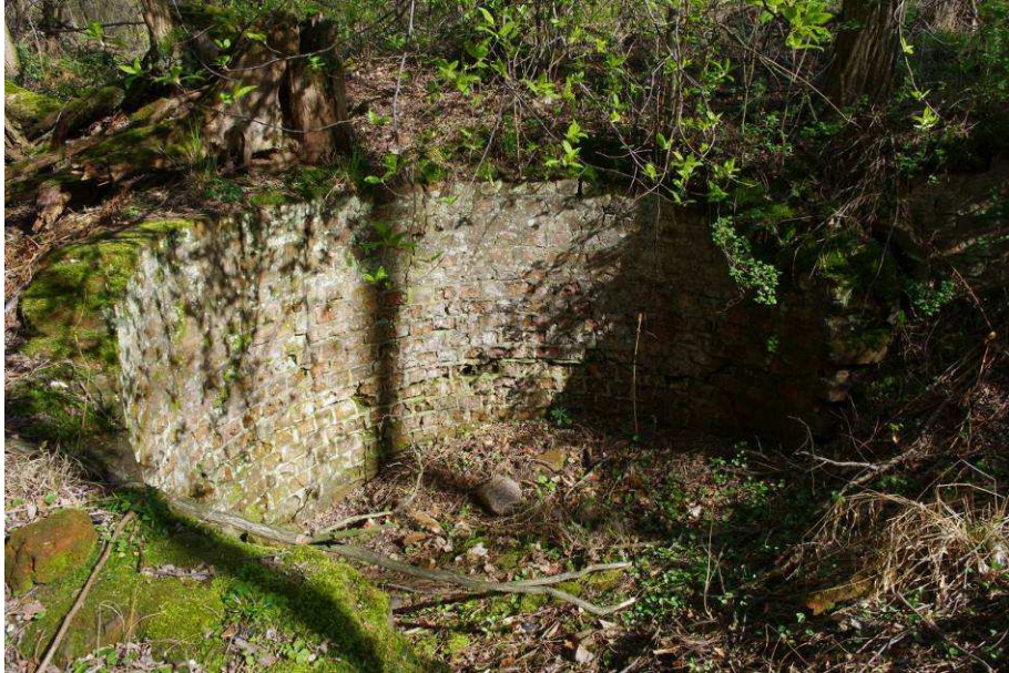
Fot. 7.22. Fragmenty ceglanej obudowy w rejonie szybu Förderschacht
