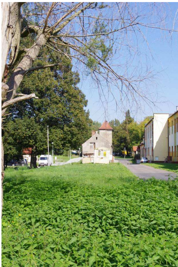
Fot.7.4. Lokalizacja szybu wentylacyjnego (Luftschacht) przy ul. Braci Gierymskich
