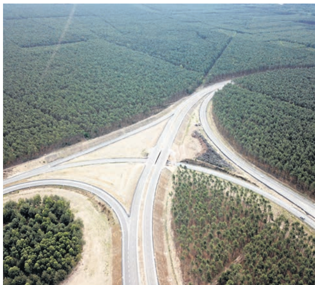
Węzeł północny ze zjazdem do przyszłej strefy przemysłowej wzdłuż drogi ekspresowej S3. Teraz rośnie tutaj las. Fot. Archiwum
