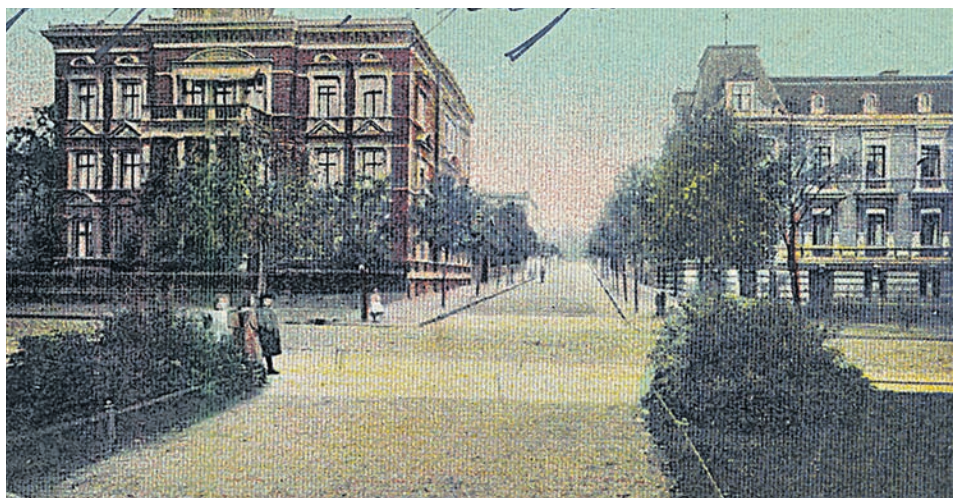
Widok na dzisiejszą ul. Bankową z początku XX wieku. Budynek po lewej (C), dzisiaj siedziba redakcji „Gazety Lubuskiej”, powstał w 1888 r. Rok wcześniej zbudowano dom po prawej stronie - należał do mistrza murarskiego Carla Mühle.
