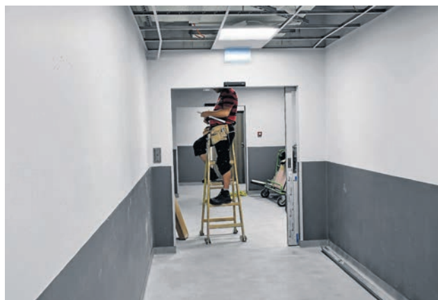
Na korytarzach trwają ostatnie prace instalacyjne
