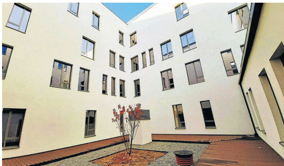
W szpitalu są dwa patia z roślinami. Przed budynkiem będzie też plac zabaw.
