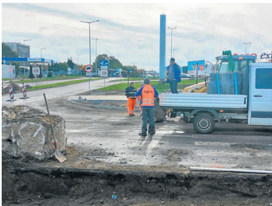
Kierowcy powinni uważać, na czas remontu została wprowadzona nowa organizacja ruchu
