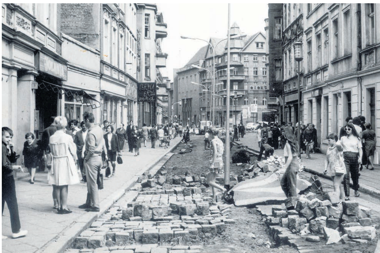
Zdjęcie opublikowane 27 sierpnia 1970 r. - trwają prace rozbiórkowe na ul. Żeromskiego
