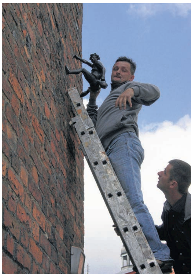
Adam Prządka i Maciej Jakuboszczak montują Odpadka na Wieży Głodowej Fot. Tomasz Czyżniewski
