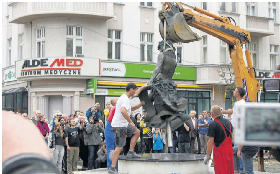
27 sierpnia 2010 r. Trwa montaż rzeźby Bachusa na cokole
