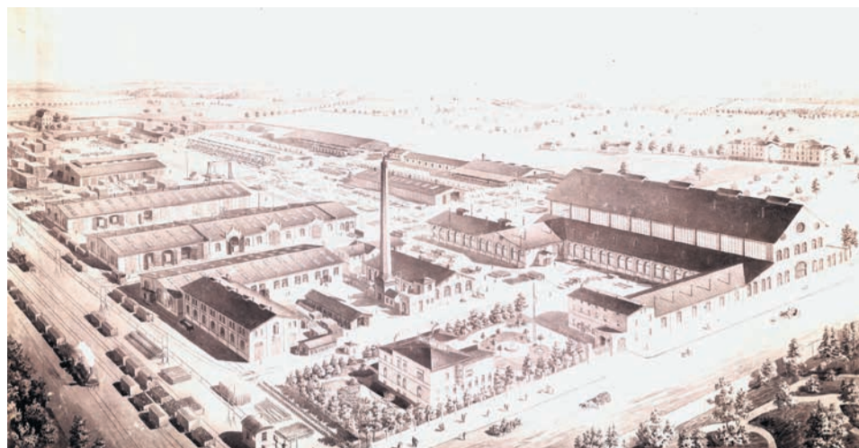
Zabudowania fabryczne zakładów Beuchelta z przełomu XIX i XX wieku
