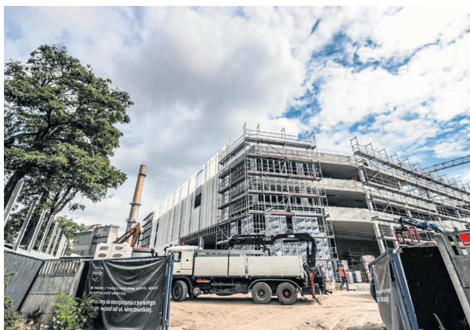
Na dawnym parkingu pod chmurką jak na drożdżach rośnie trzeci budynek Focus Mall
