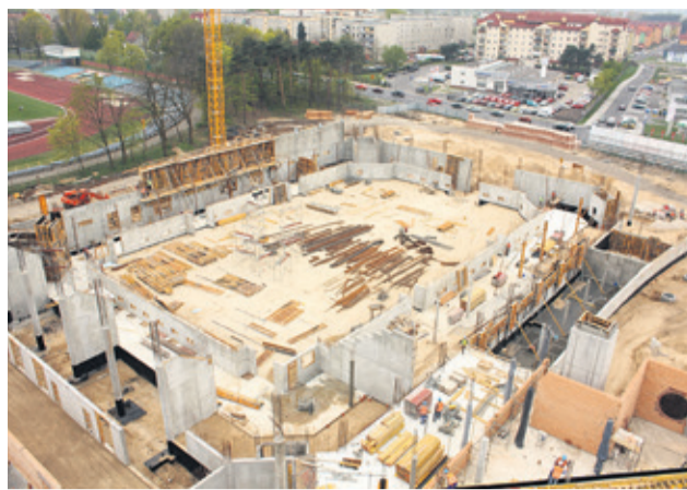
17 kwietnia 2009 r. Budowa idzie pełną parą. Z lotu ptaka dostrzeż widać już zarys przyszłej hali widowiskowo-sportowej.
