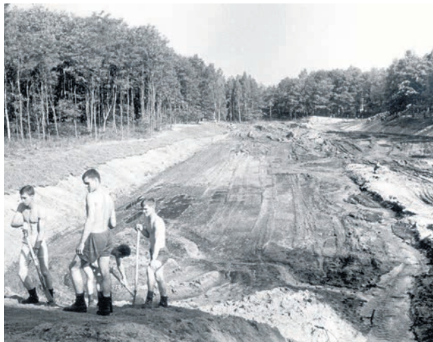
Rok 1964. Budowa basenu.
