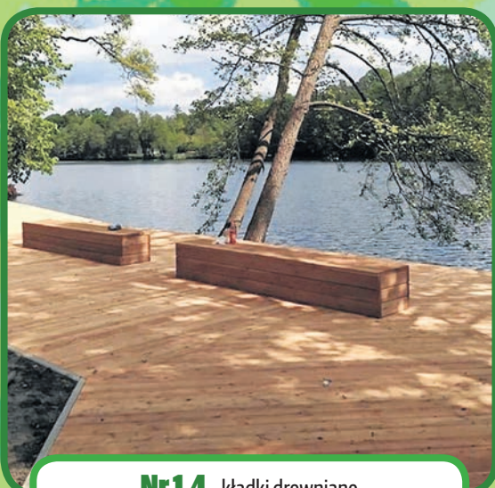
Nr 1.4 – kładki drewniane
