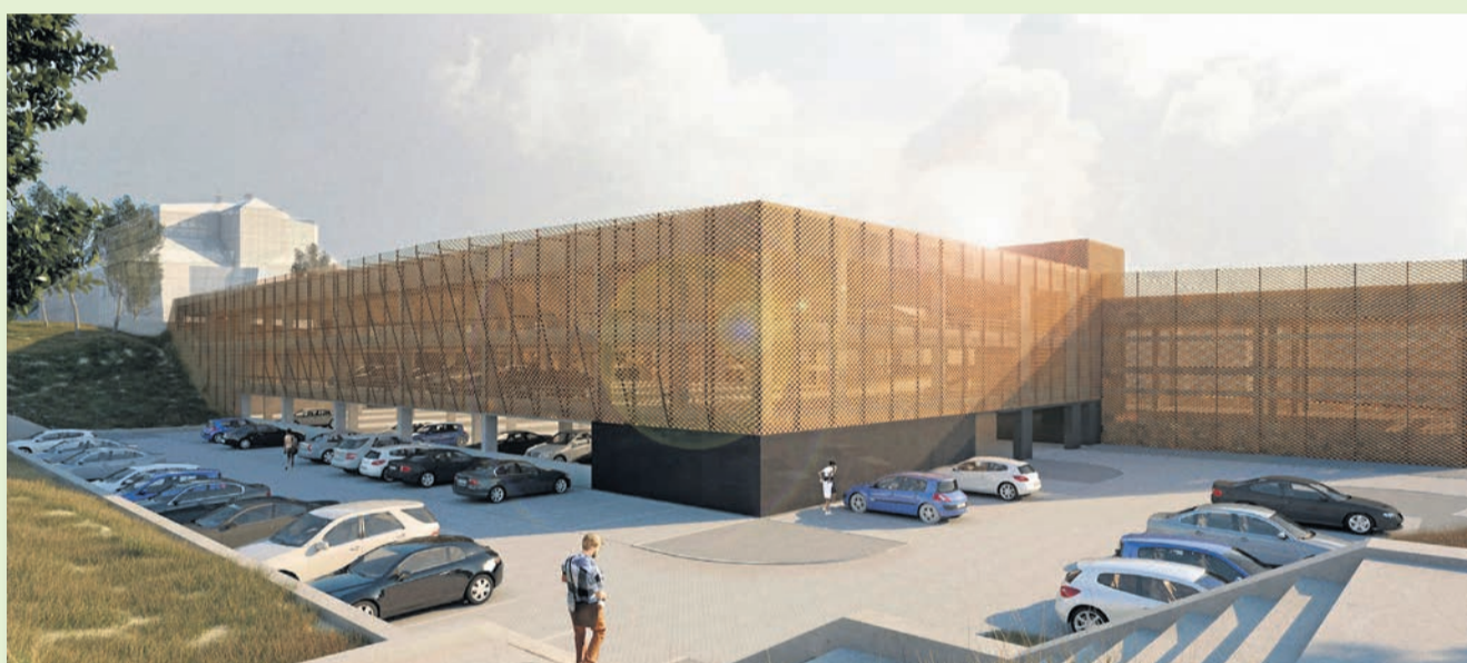
Widok na parking, którego elewację tworzy siatka cięto-ciągniona
