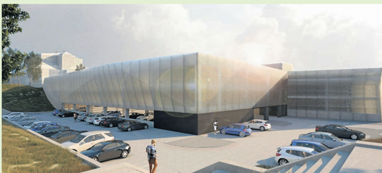
Widok na parking, którego elewację tworzy membrana - siatka mesh
