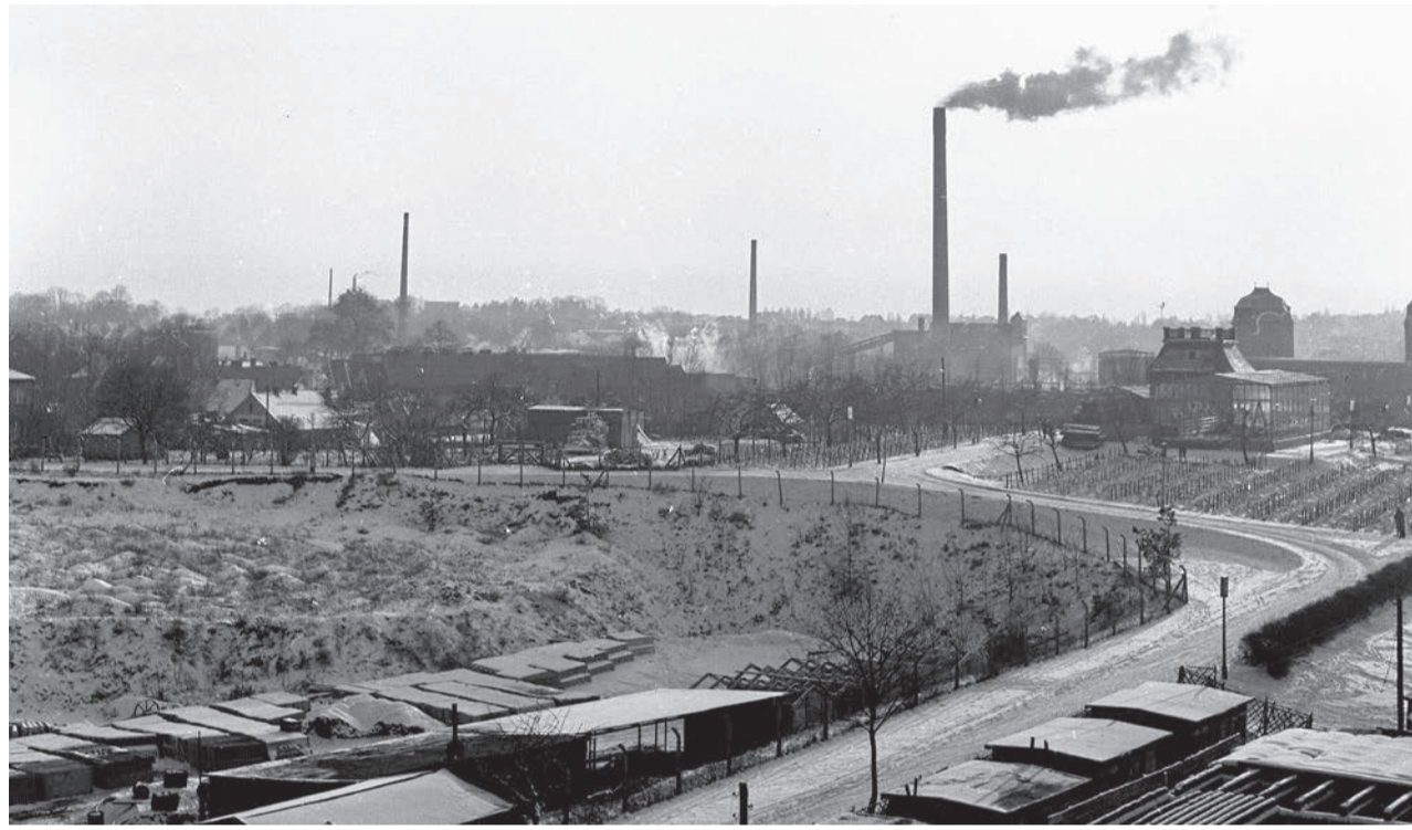
Wyrobisko na tyłach urzędu marszałkowskiego w połowie lat 60. Fragment terenu jest częściowo zasypany. Obok widać magazyn wyrobów i baraki. Po prawej Palmiarnię z dwoma szklarniami. Taki kształt miała po rozbudowie w 1964 r. W 1967 r. dobudowano trzecią halę, której nie ma jeszcze na zdjęciu.
