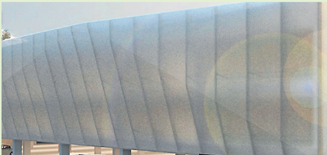
Fragment elewacji zbudowanej z membrany - siatki mesh
