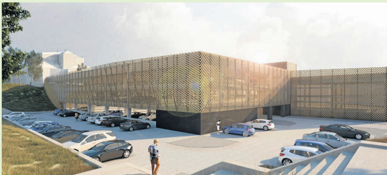
Widok na parking, którego elewację tworzą panele aluminiowe
