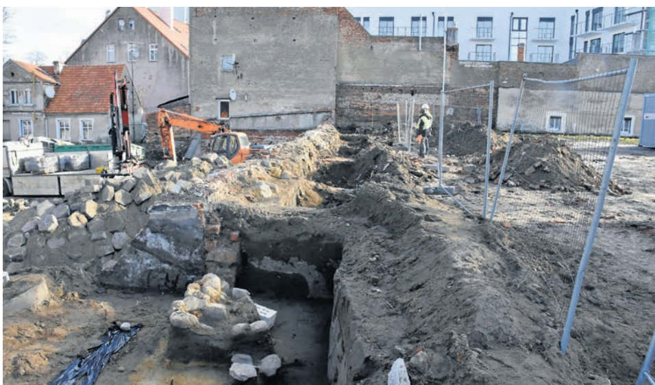
Fragment odkopanego muru cmentarnego
