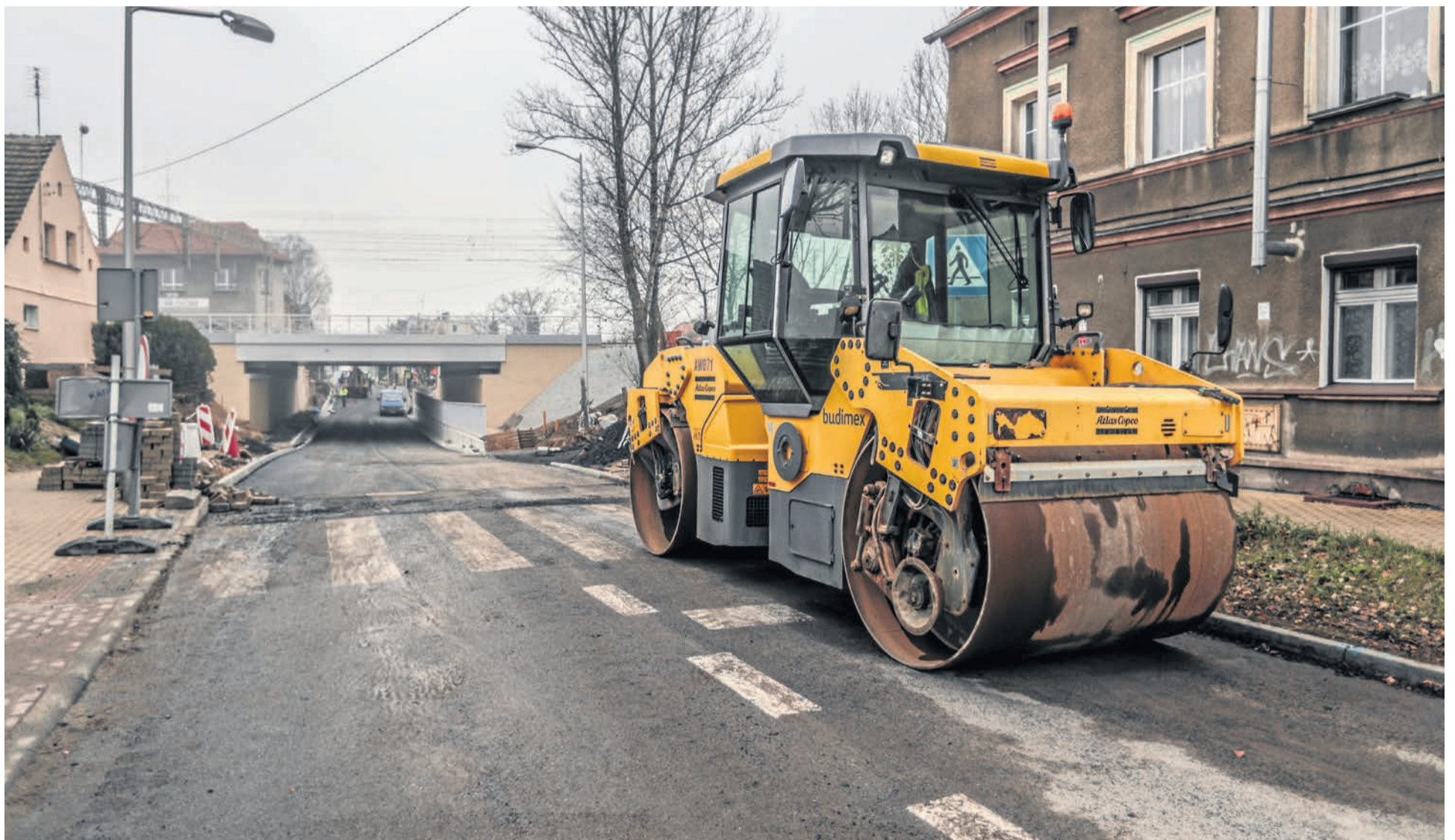
Firma Budimex kładzie asfalt, a to oznacza, że zbliżamy się do finału inwestycji
