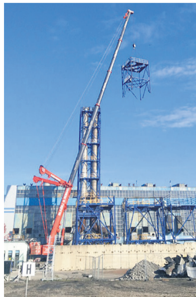
Dźwig po kawalczku „ściąga” kolejne elementy kominu Zdjęcia Archiwum Elektrociepłowni „Zielona Góra” SA
