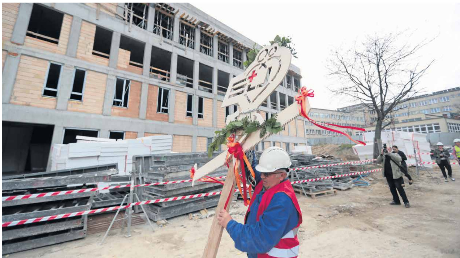
Wiecha z symbolem szpitala za chwilę „wjedzie” na dach budowanego Centrum Zdrowia Matki i Dziecka
