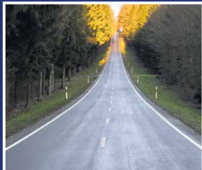
Obwodnica południowa Zielonej Góry uzyska dofinansowanie 120 mln zł od rządu
