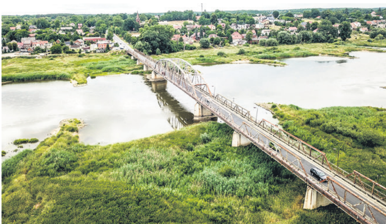
Remont starego mostu w Cigacicach kosztować będzie ok. 15 mln zł.
