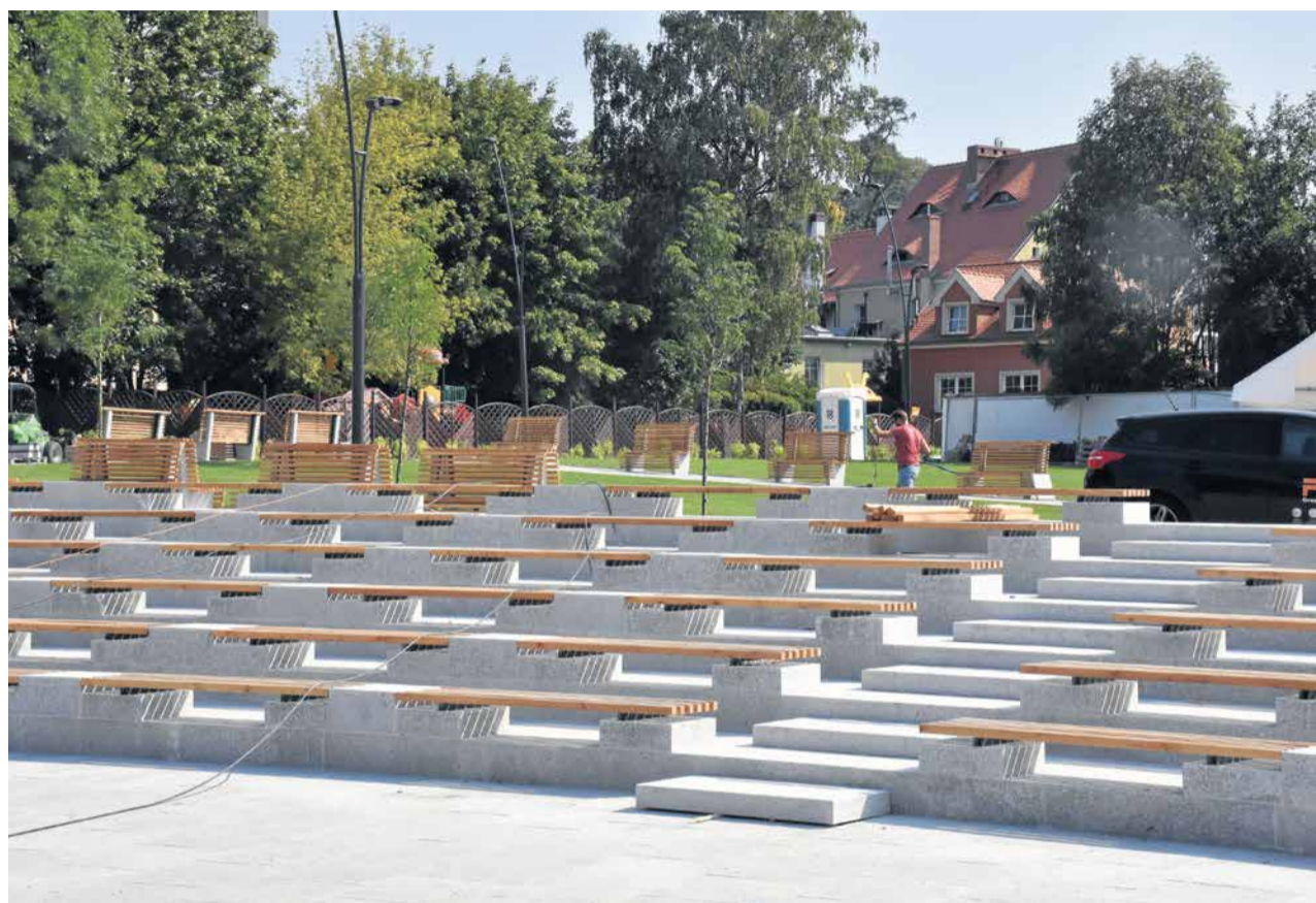
Na placu Teatralnym trwają ostatnie prace wykończeniowe. Staje się coraz bardziej zielony.
