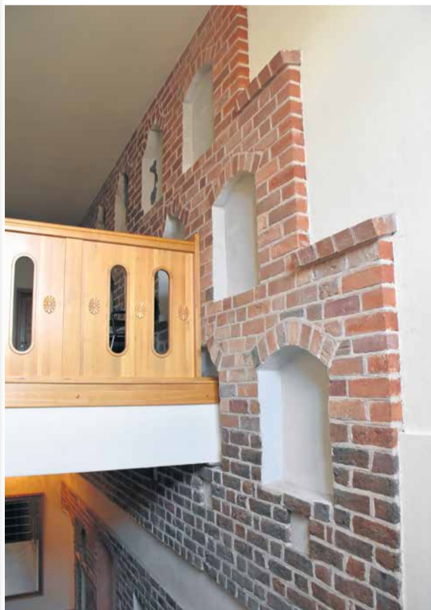
Podczas prac renowacyjnych w latach 2006-2007 odsłonięto stare ściany szczytowe ratusza, które teraz znajdują się wewnątrz budynku. Na zdjęciu klatka schodowa od strony sali ślubów USC. Fot. Tomasz Czyżniewski
