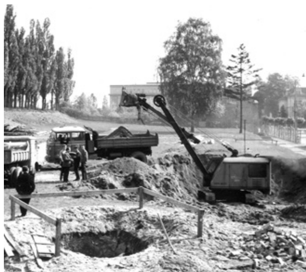
Maj 1965 r. - początek budowy empiku i poczty Fot. Bronisław Bugiel
