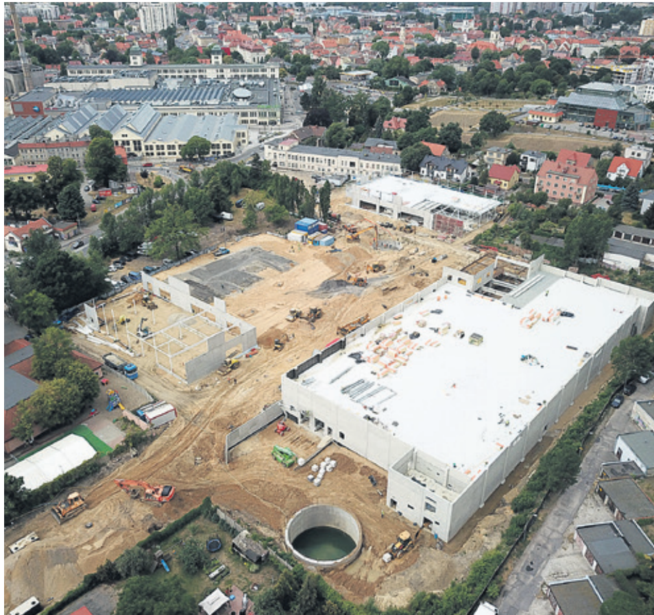
Na terenie dawnej Estrady powstaje park handlowy o powierzchni 3 tys. mkw.
