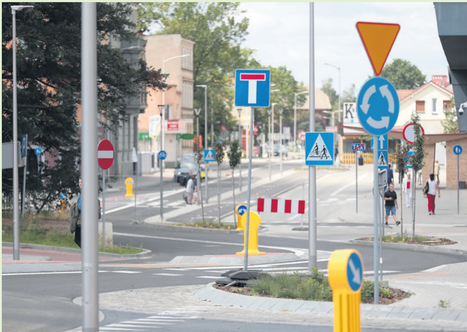
Przed otwarciem ulicy trzeba jeszcze położyć ostatnie fragmenty asfaltu
