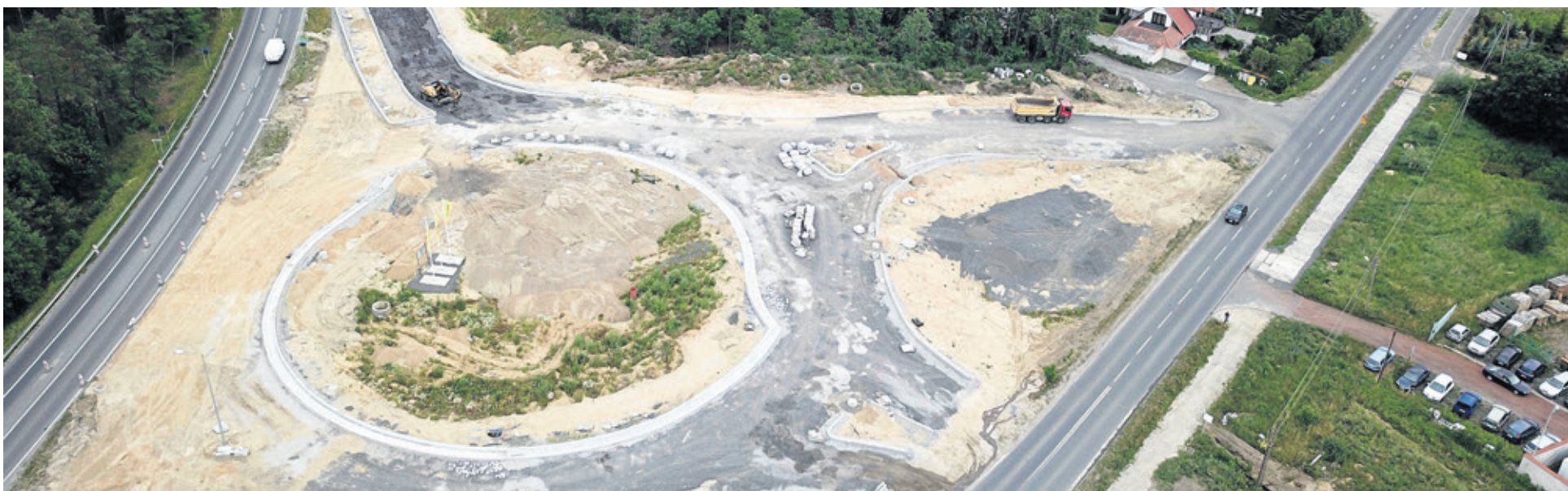
Prace na rondzie im. Andrzeja Huszczy kontynuuje firma Budimex. - Zakres prac jest duży i wymagający. To duże rondo z trzema pasami. Będzie monitorowane i oświetlone - mówią przedstawiciele wykonawcy. Fot. Piotr Jędzura
