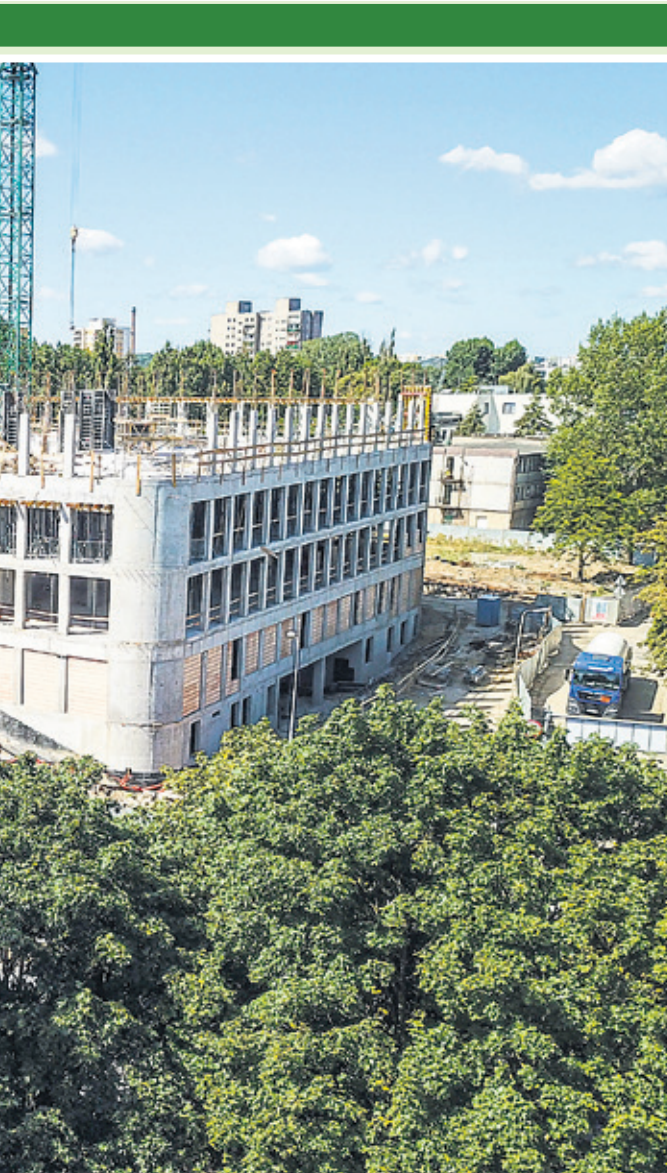
owia. Za 112 mln zł obiekt stawia Mostostal Zabrze. Ma być gotowy o inwestycja pilotowana przez marszałka województwa. Fot. łącznik Zielonogórski
