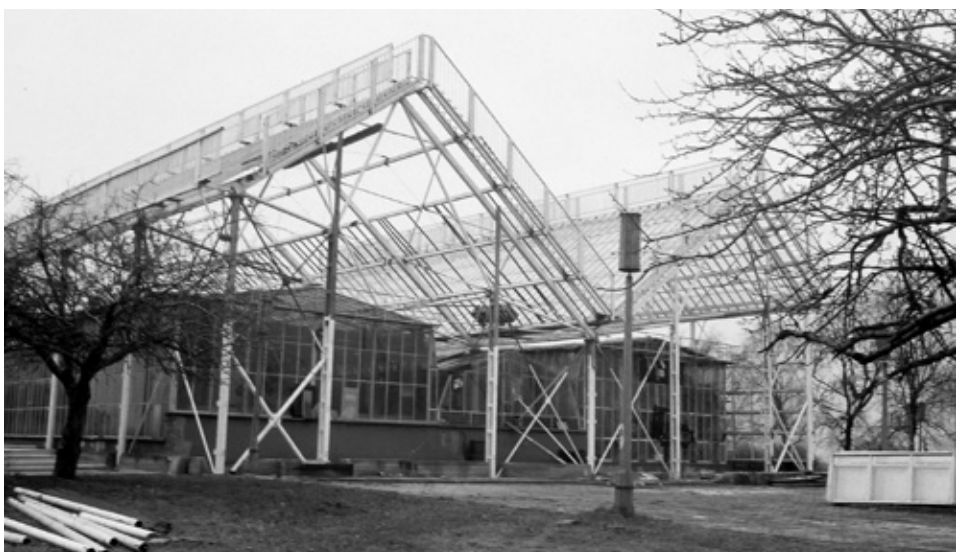
Przebudowa Palmiarni była pionierskim przedsięwzięciem – nad starą, zniszczoną konstrukcją zbudowano nową, która przetrwała ponad 20 lat Fot. Henryk Mańka
