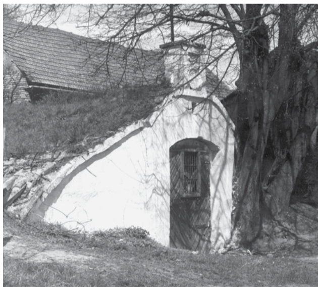
Tak przed laty wyglądało wejście do piwnicy
