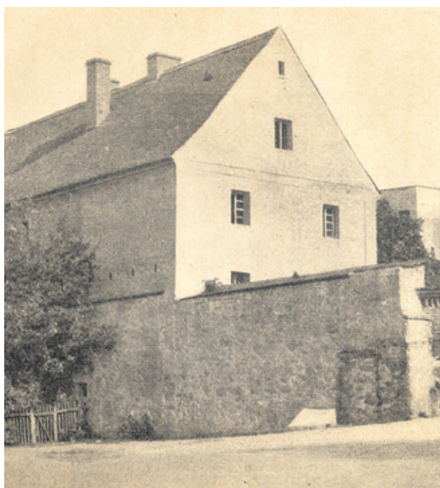
Widok przedwojenny budynku
