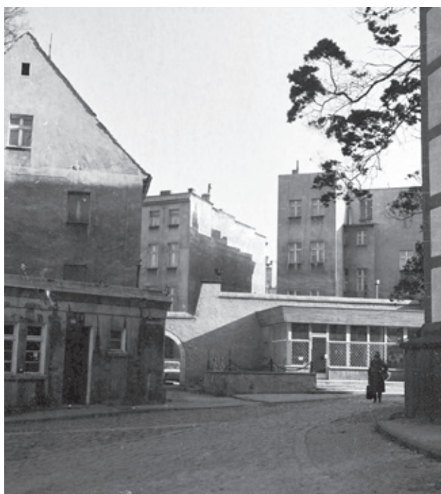
Lata 70. Przed budynkiem jeszcze stoją szaluty
