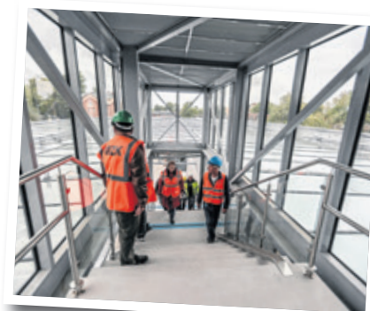
Komisja sprawdza wejście na wiadukt
