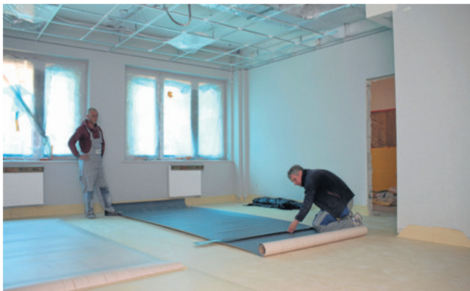
W części pomieszczeń ułożono już wykładziny, które przykryto foliami ochronnymi
