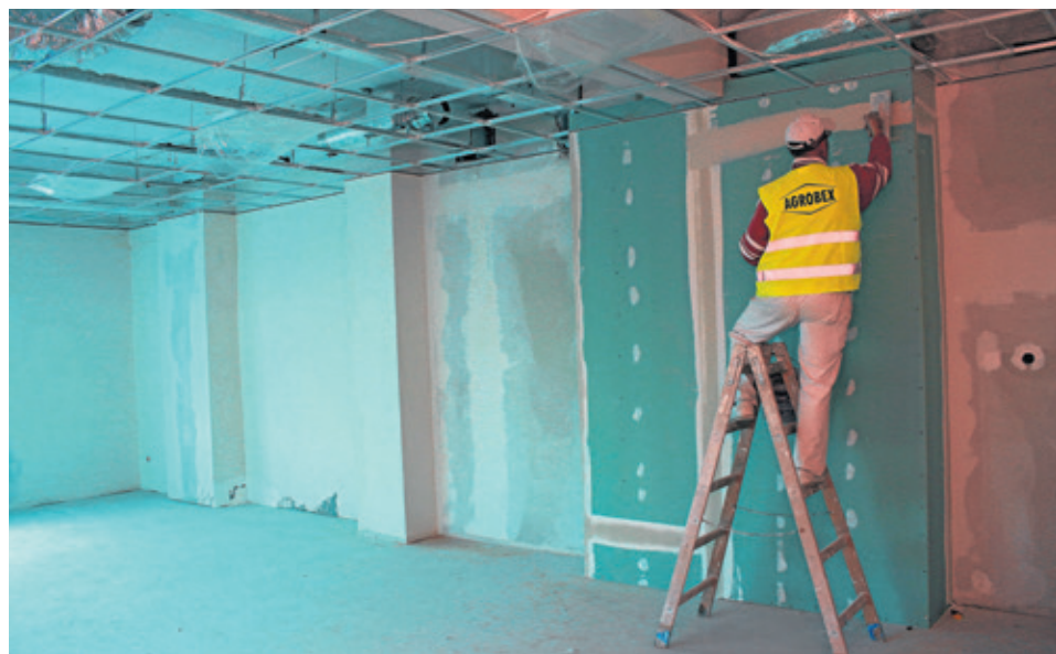
Robotnicy koncentrują się na pracach wykończeniowych
