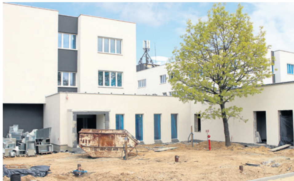
Z przodu powstał budynek, w którym znajdzie się również stołówka
