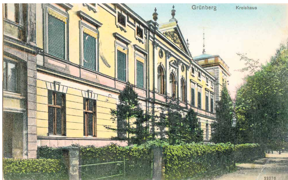
Widok przedwojenny na starostwo (A i B). Po lewej stronie widać fragment bramy przejazdowej z budynku C.
