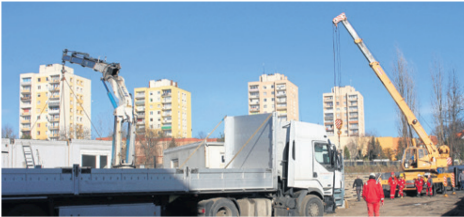
Teren po dawnej Hali Ludowej jest obecnie przygotowywany pod budowę. Trwa grodenie terenu oraz organizowanie zaplecza budowy. Fot. Paweł Nowak
