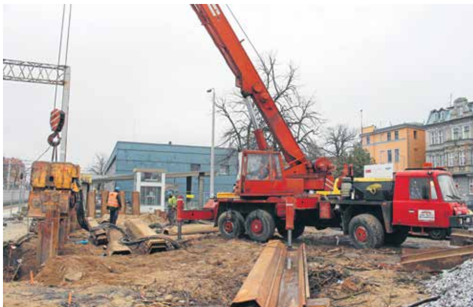
Prace nad pochylnią dla rowerów i wózków nabierają tempa
