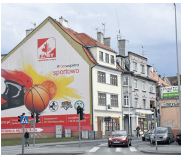
Gen. W. Sikorskiego 18 - dach - 43 399,00 zł
