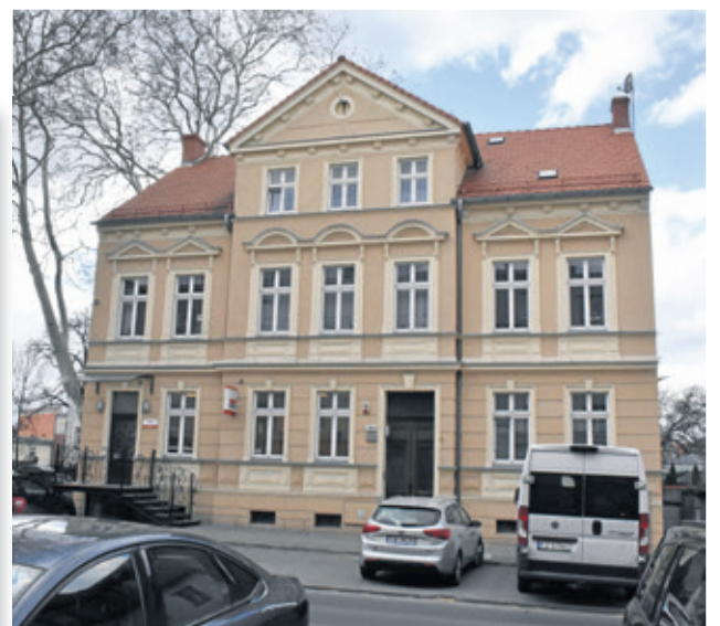
B. Chrobrego 20 - klatka schodowa - 44 901,00 zł
