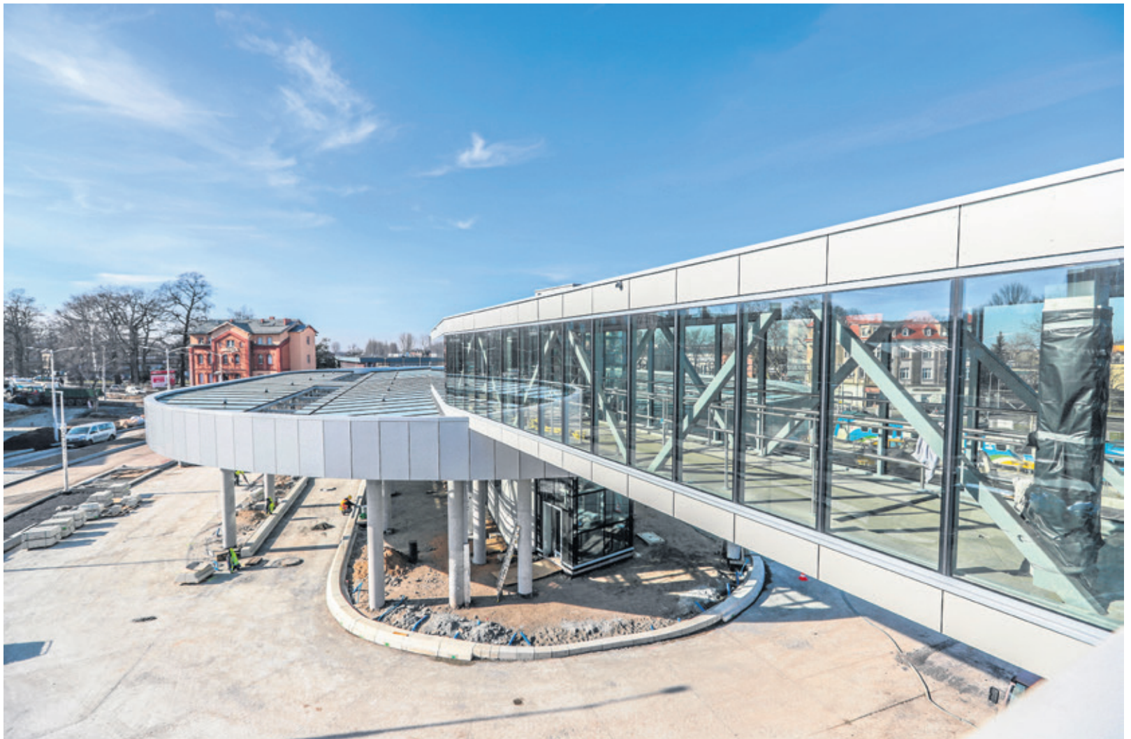
Centrum przesiadkowe widziane z wiaduktu. Do budynku prowadzi przeszklona kładka, na którą będzie można wjechać windą.
