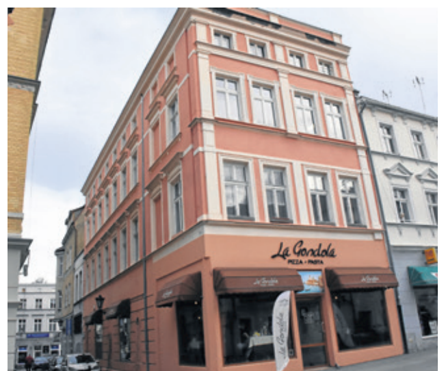
Kościelna 1/3 - renowacja stolarki - 5660 zł
