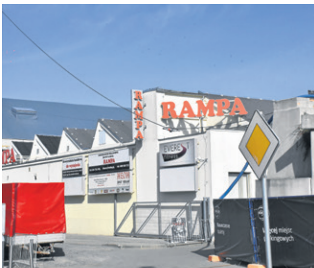
H. Sienkiewicza dz. 151/58 - II etap dachu - 140 tys. zł dofinansowania Zdjęcia Tomasz Czyżniewski
